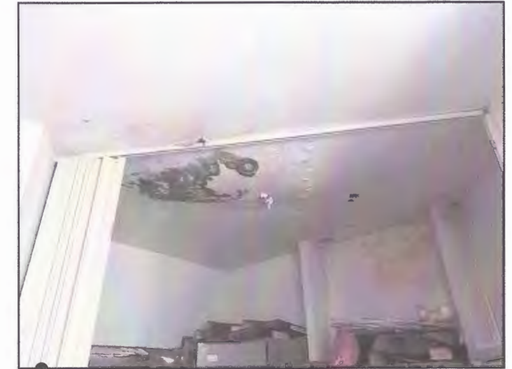
ภาพแสดงฝ้าเพดานบางส่วนที่ได้รับความเสียหายจากน้ำที่รั่วซึม
